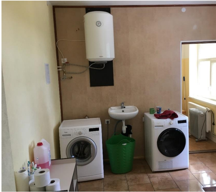
Att. Nr.11 Veļas mazgāšanas telpa
