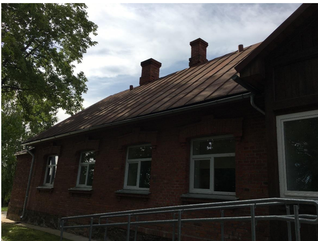
Att. Nr.2 Aprūpes iestādes ēkas fasāde. Ieejas mežglam ir invalīdu uzbrauktuve
