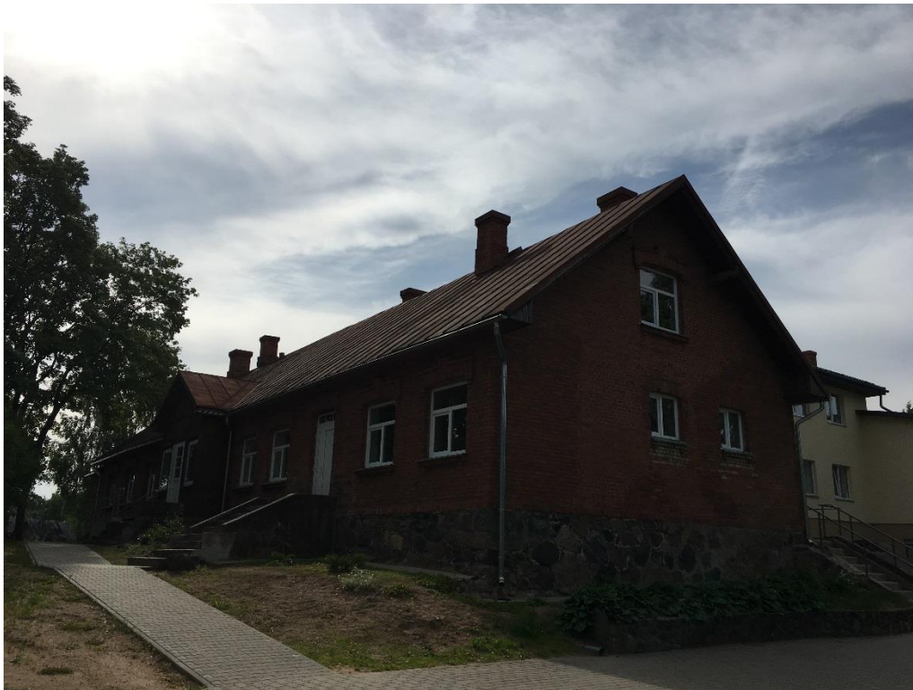
Att. Nr.1 Aprūpes iestādes ēkas fasāde. Jumta segums fiziski un morāli novecojis
