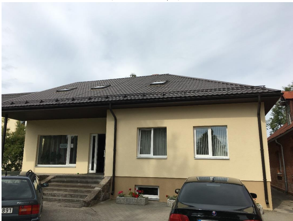
Att. Nr.16 Aprūpes iestādes administratīvās ēkas fasāde
