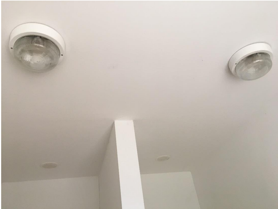
Att. Nr.13 Gaismekļi un ventilācijas difuzori virs dušas
